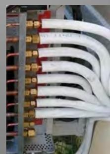
CONTRÔLE D'ÉTANCHÉITÉ DES DUDGEONS
